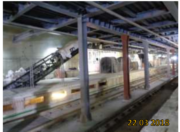
Corpo da Estação – Plataformas: 4 escadas rolantes posicionadas.
