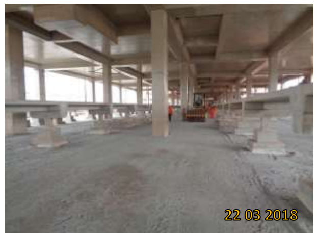
Nível Pátio (Terminal de Ônibus Vila Sônia): Plataformas de acesso aos trens e reaterro em execução.
