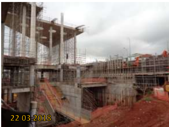
Acesso Heitor dos Prazeres: Concretagem da laje da cobertura (parcial) em execução. Armação do viário para o desvio de tráfego da Av. Prof. Francisco Morato em execução.
