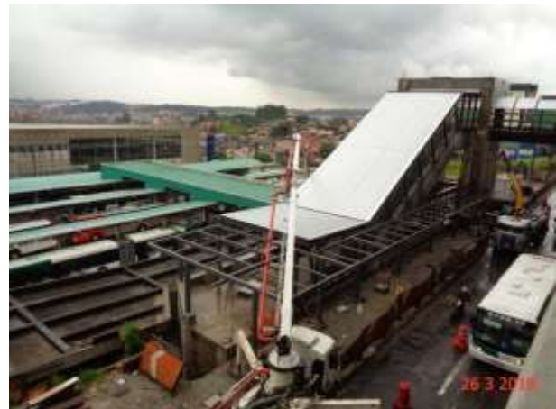
Montagem da estrutura metálica da cobertura complementar do Acesso Norte.
