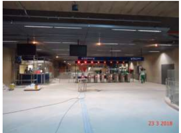
Mezanino Superior: Instalação dos vidros dos guarda corpos, linha de bloqueios, iluminação e SSO.
