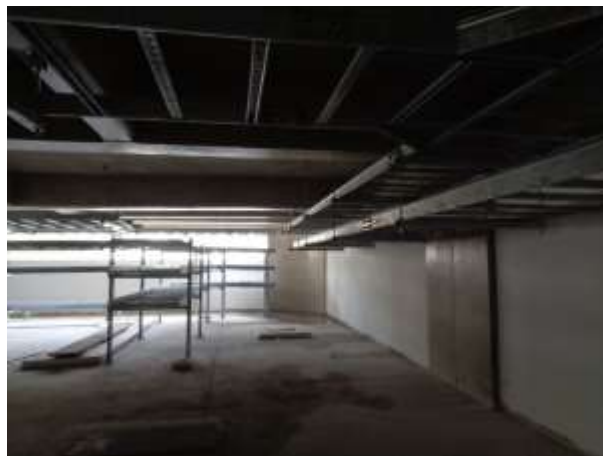
Instalação do bandejamento.
