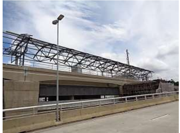
Montagem da cobertura metálica da Estação
