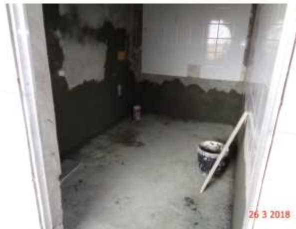
Execução do revestimento dos sanitários.
