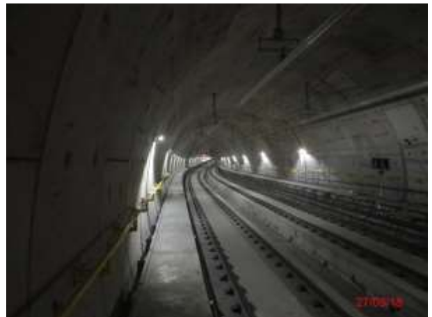
Trecho Moema – AACD-Servidor: Concluída via permanente
