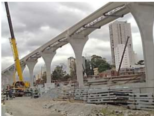
Lançamento da passagem de emergência.
