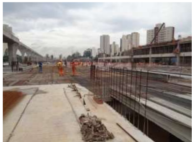
Execução da laje sobre o piscinão e Bloco A.
